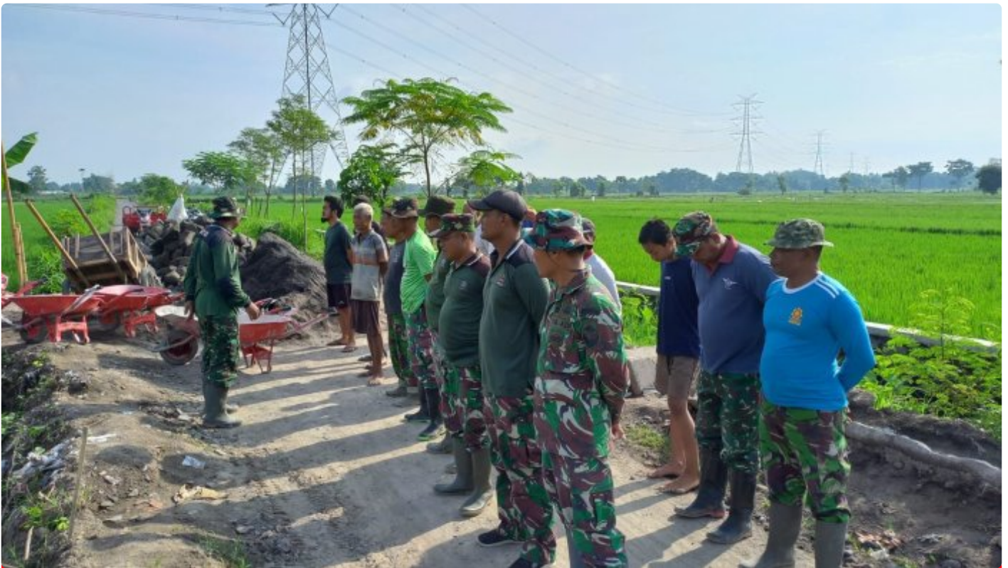
TMMD Desa Bero Trucuk Sasarkan Talud Sepanjang 710 M
